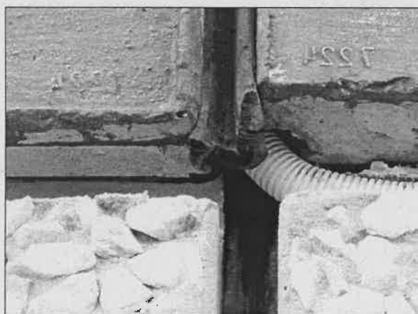
č. 11 Detail křížení spár
